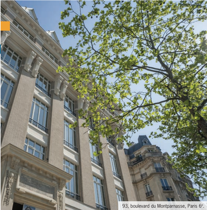
93, boulevard du Montparnasse, Paris 6 e .
