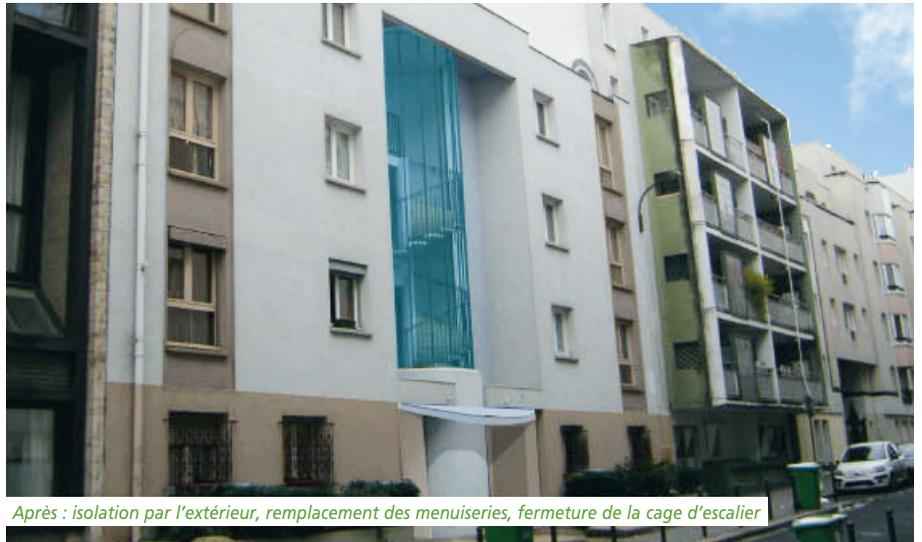
Après : isolation par l'extérieur, remplacement des menuiseries, fermeture de la cage d'escalier
